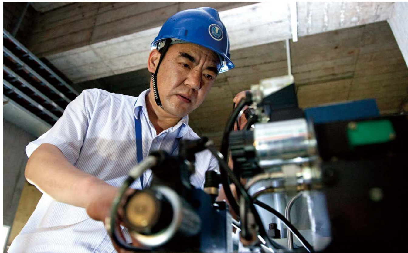
三峡电站检修
