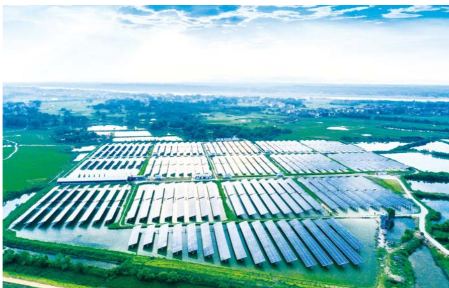
江西省万安县窑头镇通津村渔光互补扶贫项目
