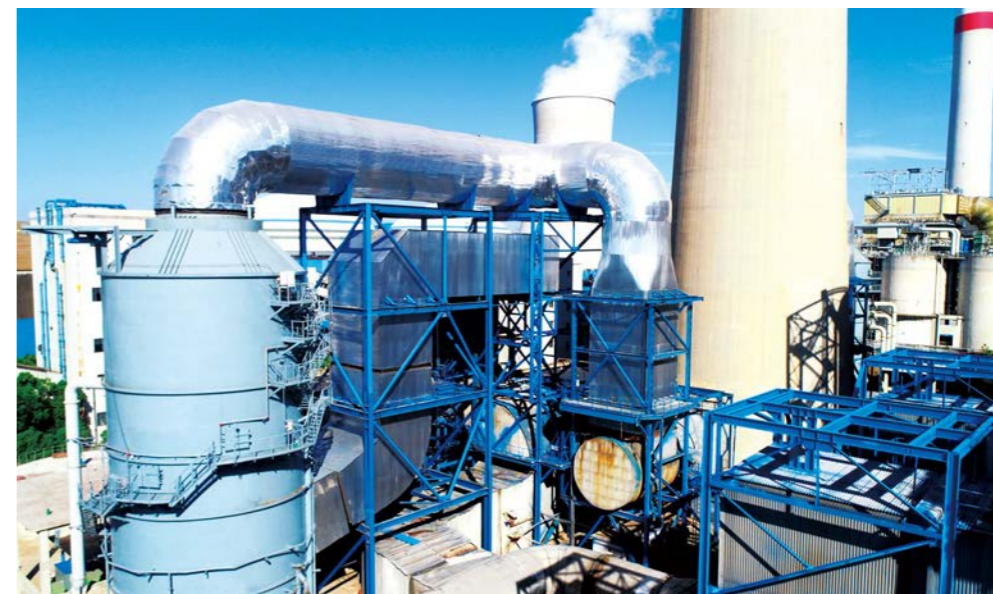
湖北能源鄂州电厂一期机组新增吸收塔二级塔
