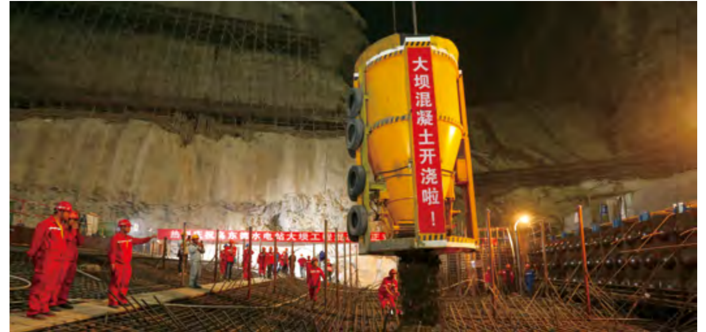
乌东德大坝混凝土浇筑
