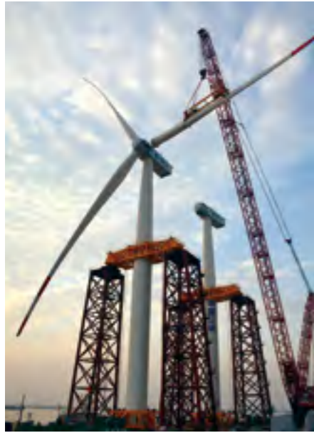
响水风电整体吊装
